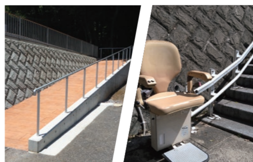
スロープや昇降機も設置しており お参りの方にも優しい霊園です。
